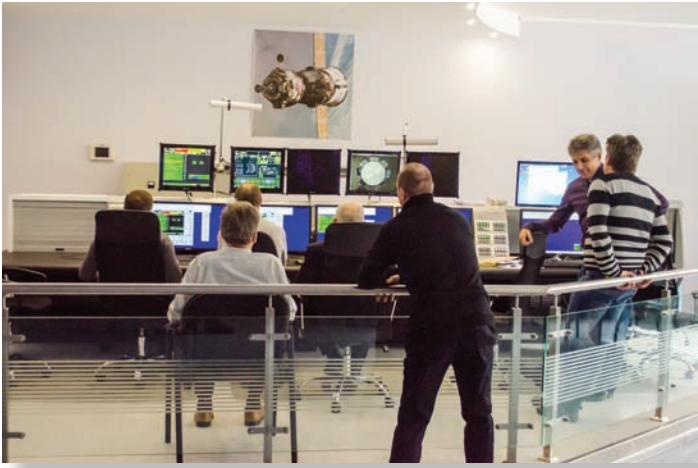
Пульт контроля и управления
